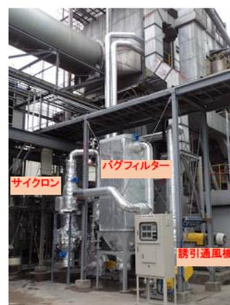
Fig. 3 サイクロン実証試験設備全景
